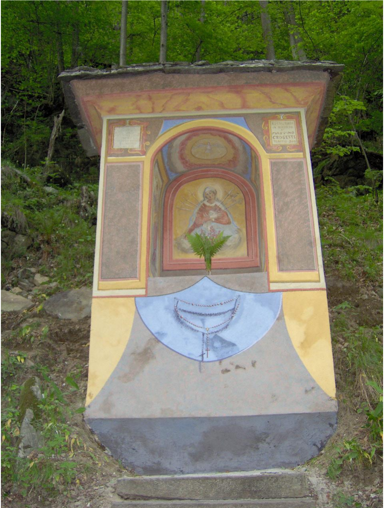
LA CAPPELLA DELLA RAMANSCIUNA AL TERMINE DEI LAVORI DI RESTAURO
