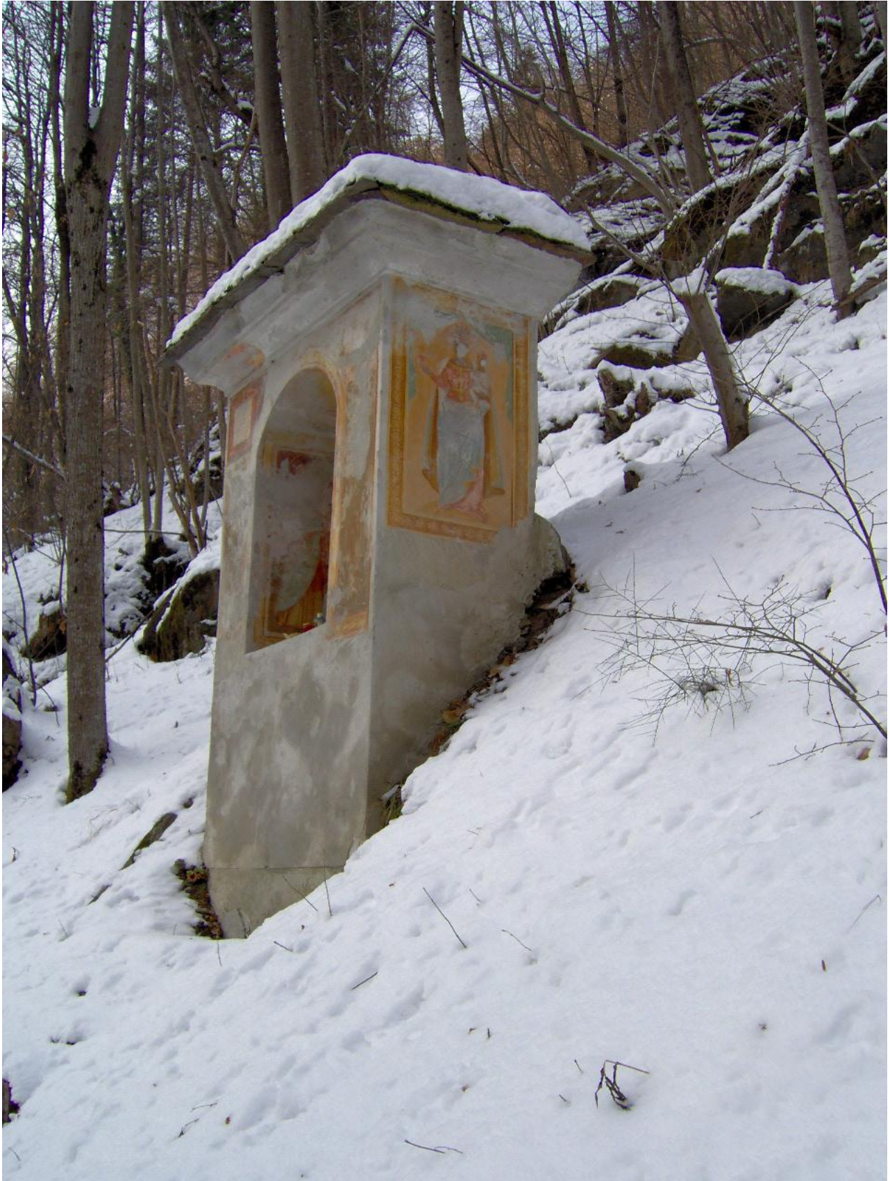
VEDUTA INVERNALE DELLA CAPPELLINA EDIFICATA NEL LONTANO 1655
